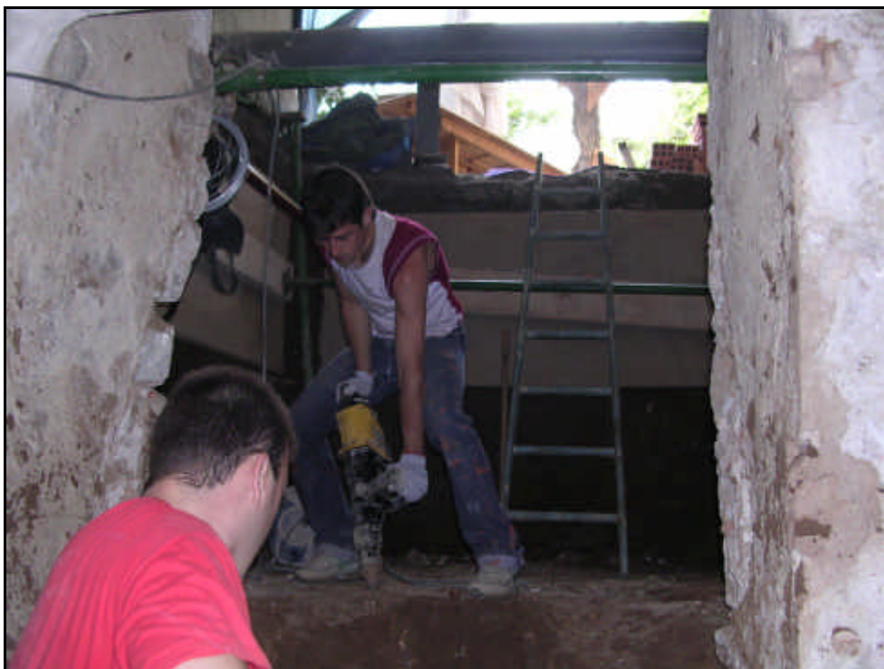
Fotografia 3: Operaris començant a rebaixar U. E. 108
