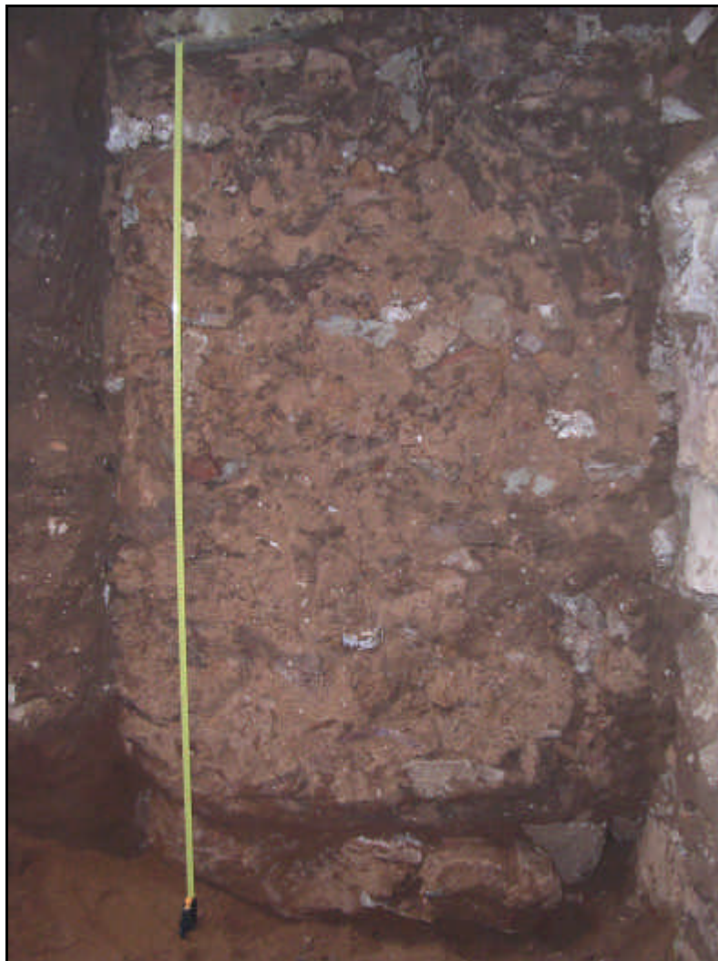
Fotografia 6: Mur U. E. 110 en tota la seva potencia.
