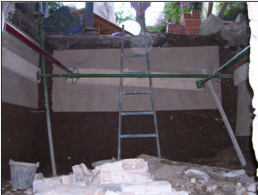
Fotografia 2: Vista de la fossa 100 des de l'interior del soterrani.
